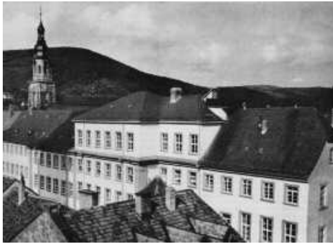
ehemaliges Schulgebäude in der Kettengasse
